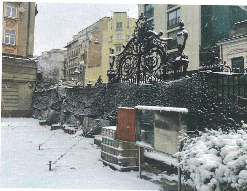
Foto 44. Prezintă prinderi locale cu sârmă oțelită cu piroane pentru a nu se prăbuși peste trotuar.
