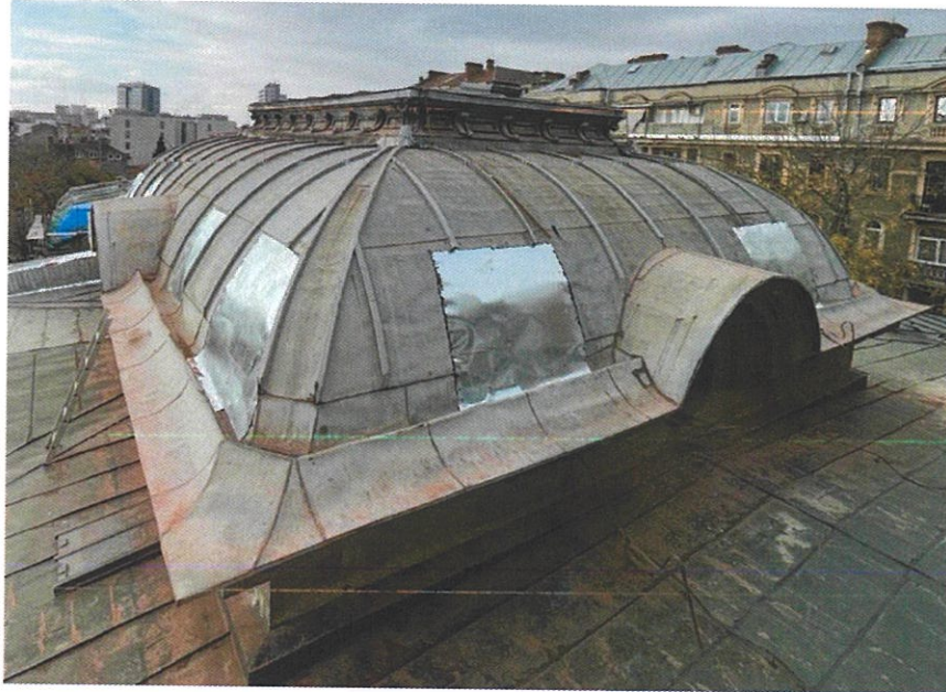
Foto 32. Sunt realizate pe porțiunile curbe ale acoperirii, cu învelitori din solzi de tablă (zonă cupolă aulă, zone cupole turnuri pe fațada principală).
