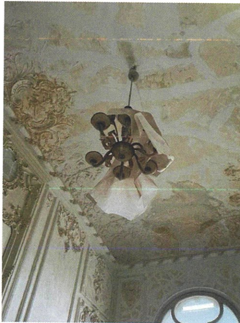
Foto 15, 16. Componentele artistice metalice rămase pe poziție (candelabre), sunt neprotejate sau sunt acoperite cu folie de protecție parțial desprinsă.
