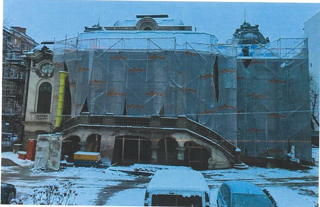
Foto 36. Schelă exterioară metalică, amplasată pe fațada principală și cea din curtea din spate.
