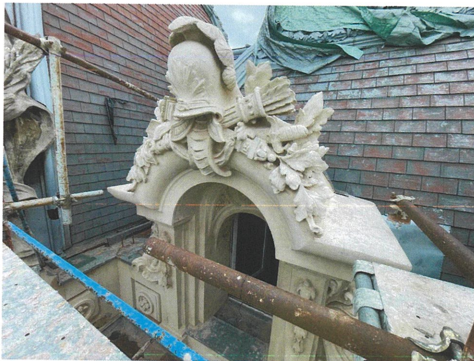
Foto 26. Detaliu element decorativ, unde s-a efectuat intervenții de restaurare.
