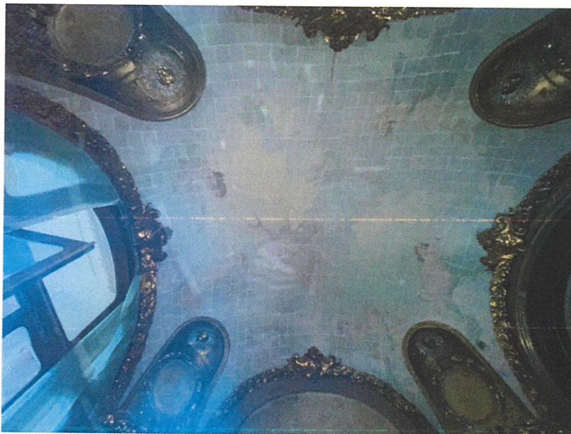
Foto 01. P 02, Hol - Suprafețele picturale sunt conservate cu hârtie japoneză.
