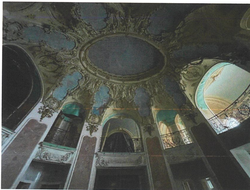
Foto 02. P 18, Aula - Suprafețele picturale sunt conservate cu hârtie japoneză.
