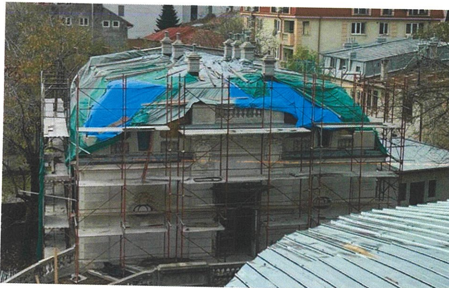
Foto 39. Învelitoarea este complet demontată, fiind acoperită temporar cu folie de polipropilenă și prelate, stabilizate cu lați de lemn dispuși pe șarpantă.
