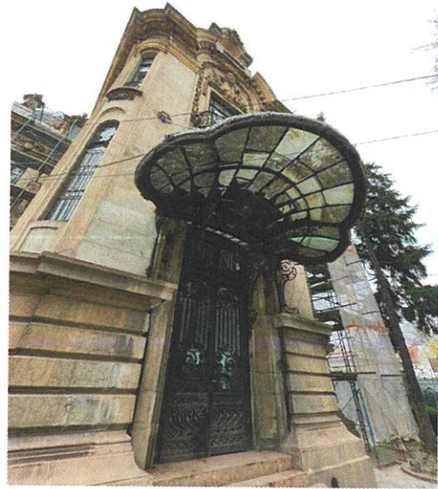
Foto 13, 14. Ușa din fier forjat, intrarea laterală stângă, casa scării P.30
