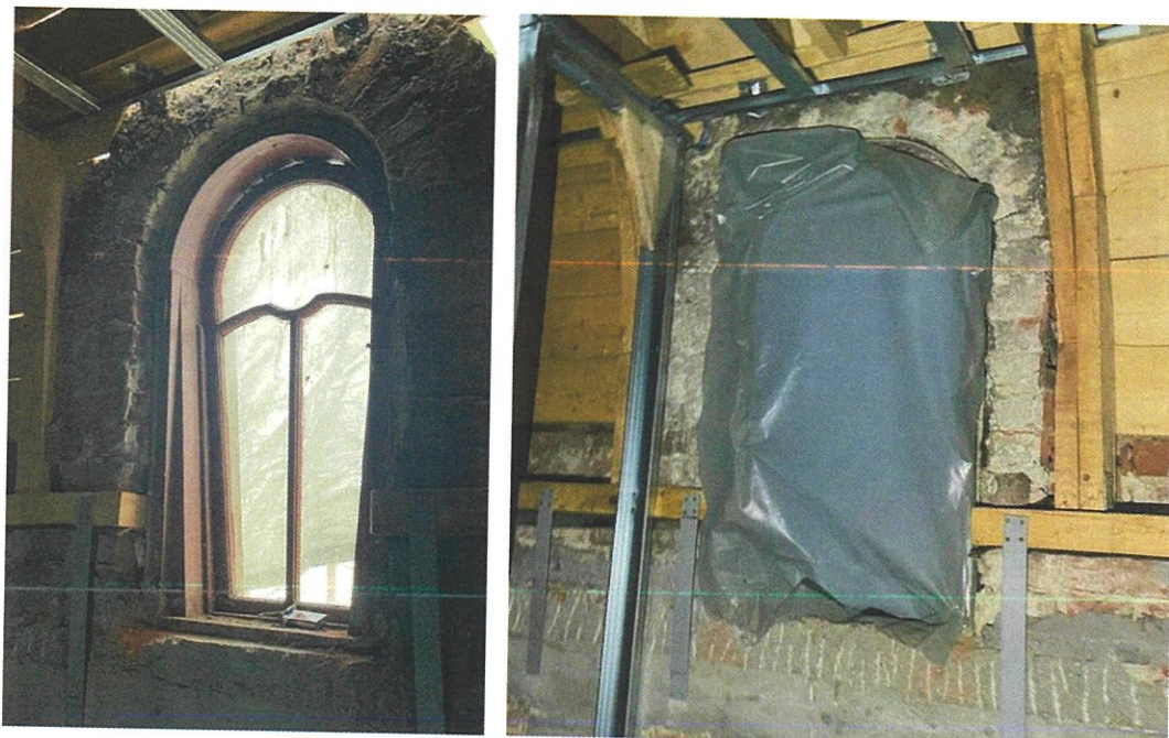
Foto 42. Unele goluri de fereastră mențin tocurile și tâmplăriile de lemn sau sunt blocate cu folie de polipropilenă prinsă de ramele ferestrelor.
